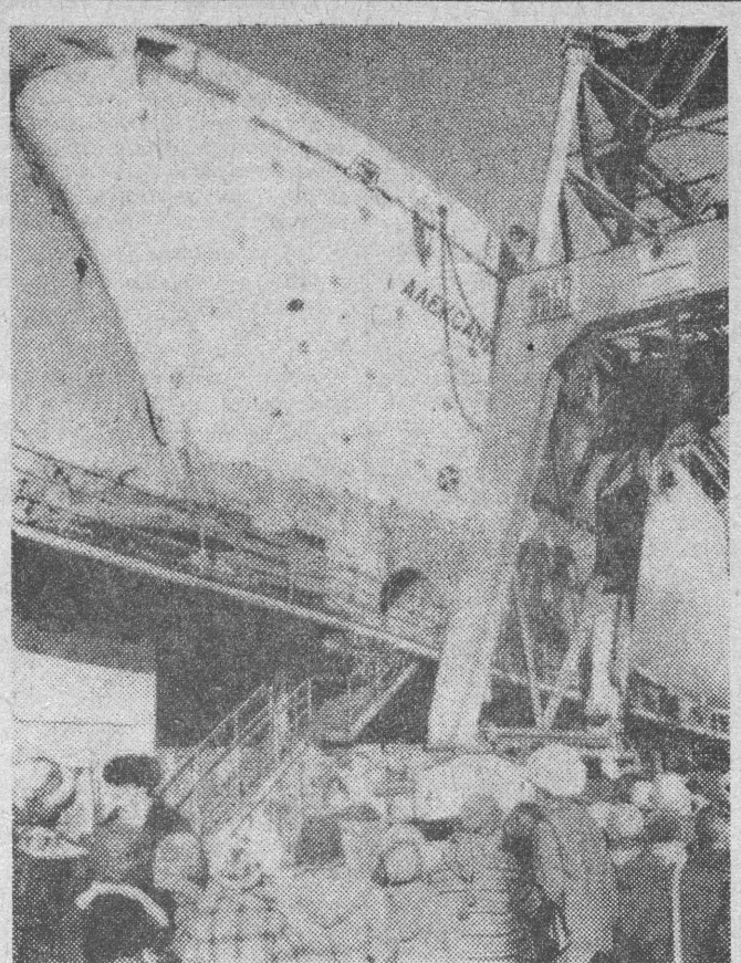
W Stoczni Szczecińskiej im. A. Warskiego zwodowano drugi w tym roku statek — „Akademik Aleksandr Neszmeyanov”. Jest to jednostka z serii naukowo-badawczej, budowana na zamówienie Akademii Nauk ZSRR o dł. 110,9 m, nośności 6300 DWT i prędkości 16 węzłów.
