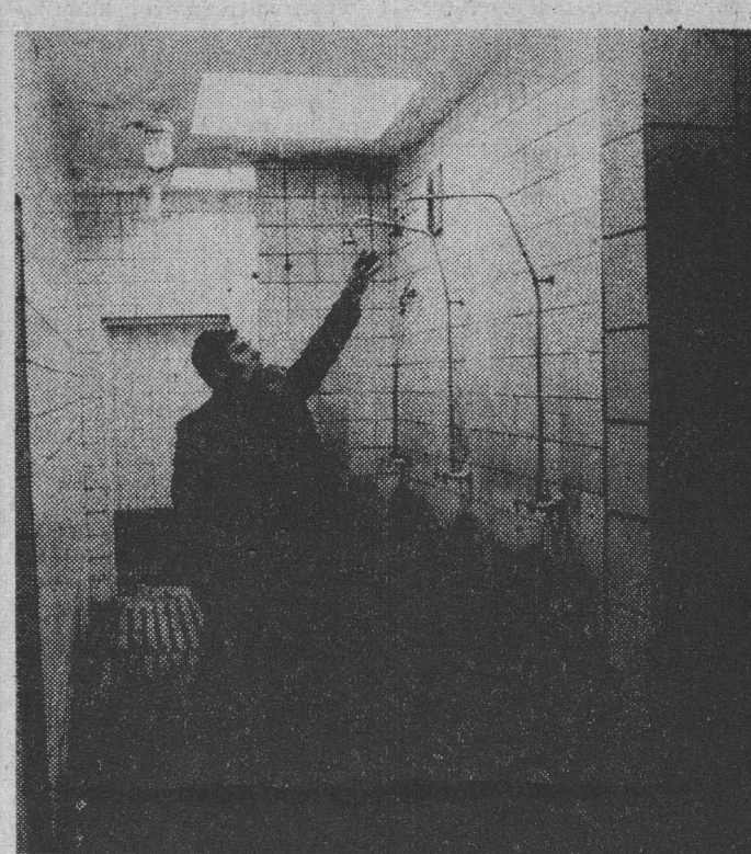
W pomieszczeniach z natryskami wymieni się terakotę, glazurę i naprawi się urządzenie wodociągowo-sanitarne.
