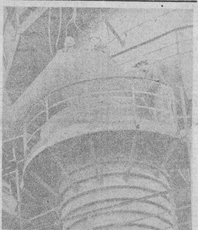
W Zakładach Chemicznych „Altorna” w Krakowie wznowiony jest oddział trójpodsiortanu sodu — jednego z podstawowych składników proszków do prania. Oddanie instalacji w 1982 roku powinno się przyczynić do zwiększenia produkcji proszku. Obecnie trwa montaż i budowa całej instalacji prowadzona przez dywizję Krakowskiego Mostostatu.
