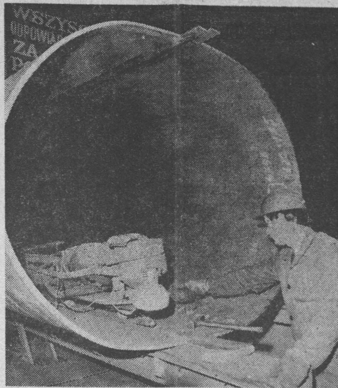
Wydział rur wadliwie spawanych Huty „Ferum” w Katowicach posiada dwa ciągi produkcyjne, wytwarzające łącznie średnicy od 500 mm do 2020 mm. Przetworzone one są do układania gazociągów, ropociągów, magistrali ciepłowniczych. Odbiorcami ich jest budownictwo, energetyka, górnictwo, rolnictwo.
