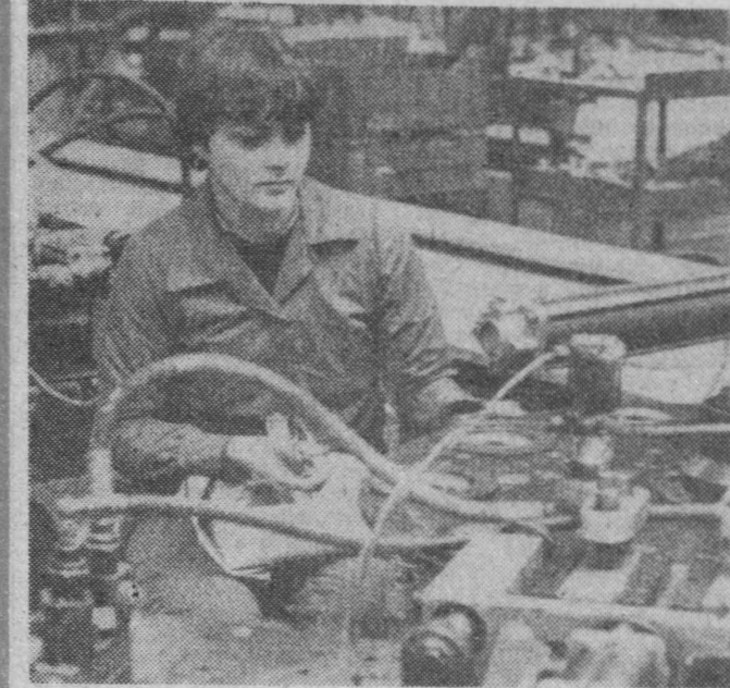
Wytwórnia Filtrów w Sędziszowie Małopolskim rozpoczęła seryjną produkcję nowego typu filtrów oleju, stosowanego w silnikach ciągników „Ursus”. NA ZDJĘCIU: na linii montażowej filtrów. CAF — Łokaj — telefoni
