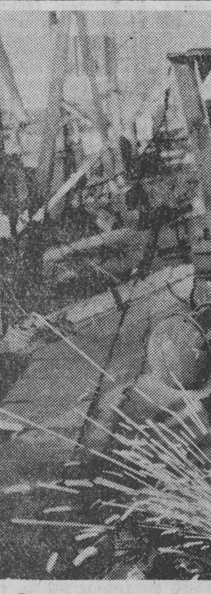
Brygada mistrza Aleksandra Werpachowskiego spawa konstrukcje mostowe. Fotoreportaż „Budujemy mosty” zamieszczamy na str. 3—4. Fot. Zdzisław Lenkiewicz
