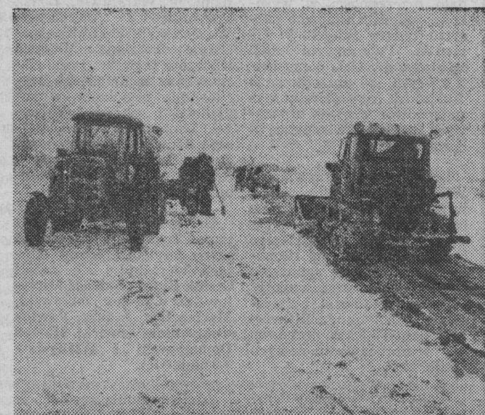
Przywieziona zawartość przyczep jest natychmiast rozgarniana i równana przez spychacz. Przez cały czas ciągniki są w ruchu — z piaskiem na drogę i z powrotem po ładunek. Fot. Zdzisław Zaremba
