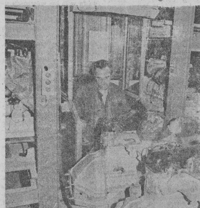
W wysokiej części magazynu rolę najważniejszą pełni składowarka, która kierowana przez Janusza Świdarskiego dostarcza palety z towarami na bardzo precyzyjnie określone miejsce.
