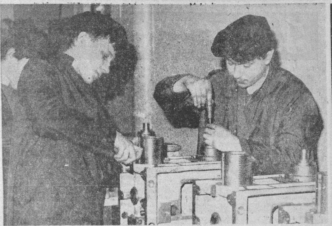
Wiertarka WSD — 10 cieszy się obrotym „wzrokiem” na krajowym rynku. Wszystkie prace przy produkcji poszczególnych jej detali i montażu wykonują uczniowie pod nadzorem instruktorów.
