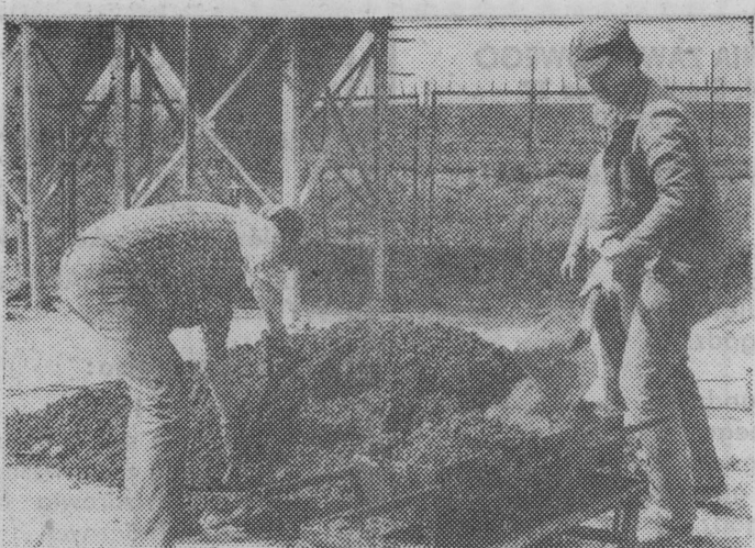
ZMS-owcy przy produkcji kostki betonowej na placu giżyckiego PBR-ol.
