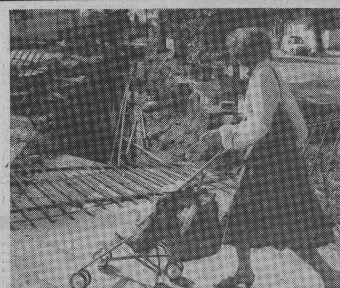
Balaganierska robota i takiż sposób zabezpieczenia wykupu przed wypadkiem.
