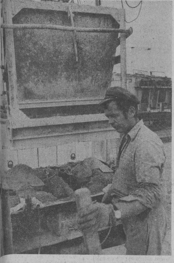
Zalanie betonem formy do fundamentów pod słupy trakcji elektrycznej. Przy pracy Józef Komorowski.
