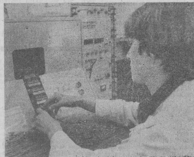
Ostatni etap produkcji. Krystyna PŁOCIENNIK kontroluje wartości elementów.
