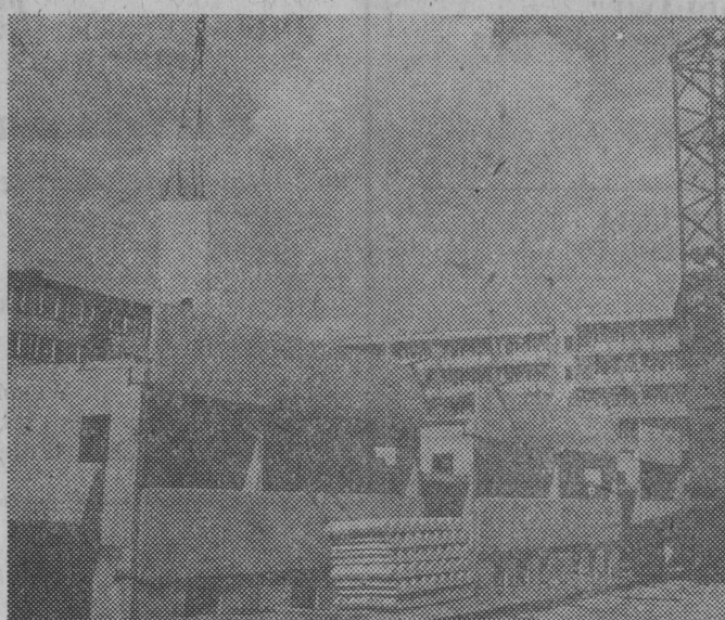
Powstają nowe bloki na osiedlu XXX-lecia PRL. Przy pracy brygada Henryka Zabkowskiego.
