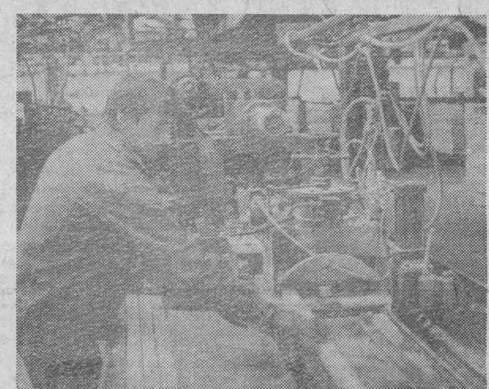
Na specjalnym urządzeniu Andrzej Anisko łączy elementy drewniane.
