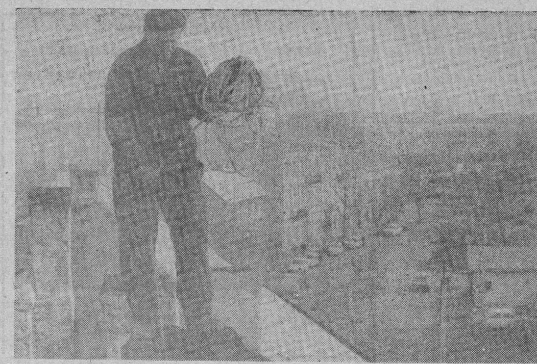
Na wielu dachach trzeba być ekwilibrystą.
