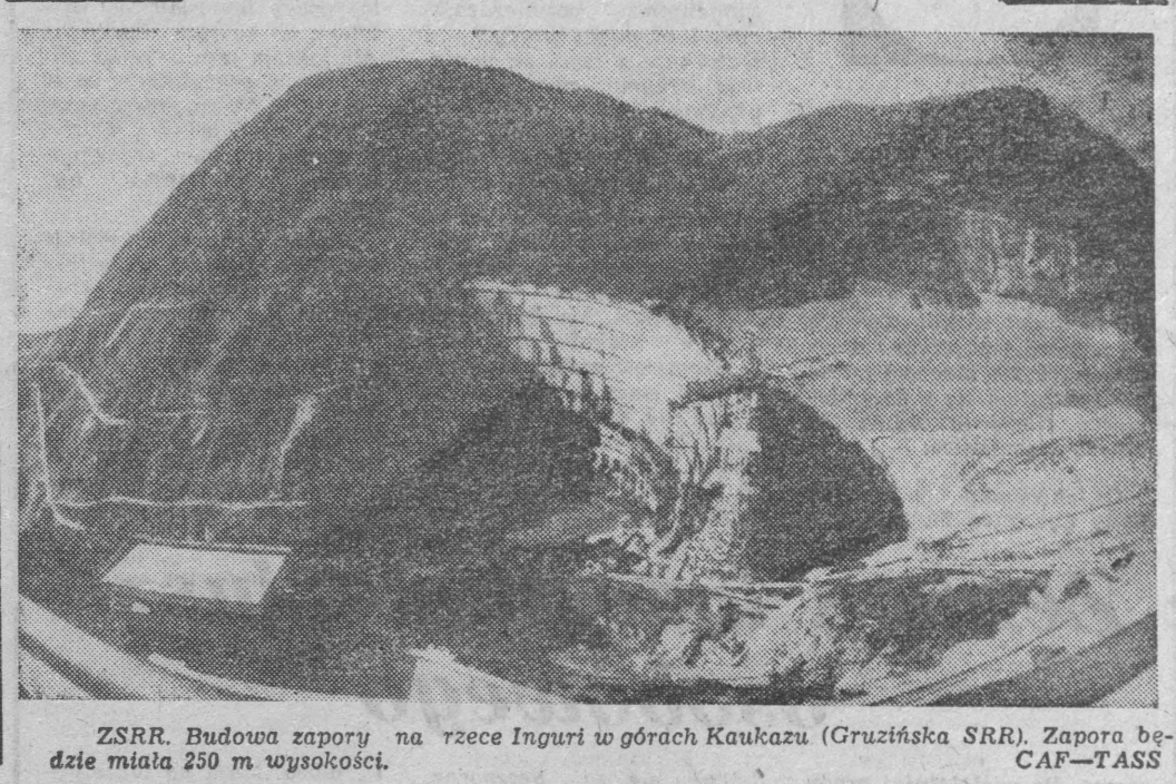
ZSRR. Budowa zapory na rzece Inguri w górach Kaukazu (Gruzińska SRR). Zapora będzie miała 250 m wysokości. CAF—TASS
