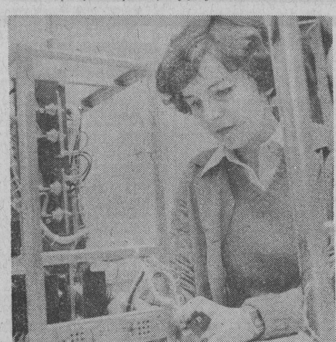
Montaż układów elektrotechnicznych. Przy pracy Jadwiga Zalewska.
