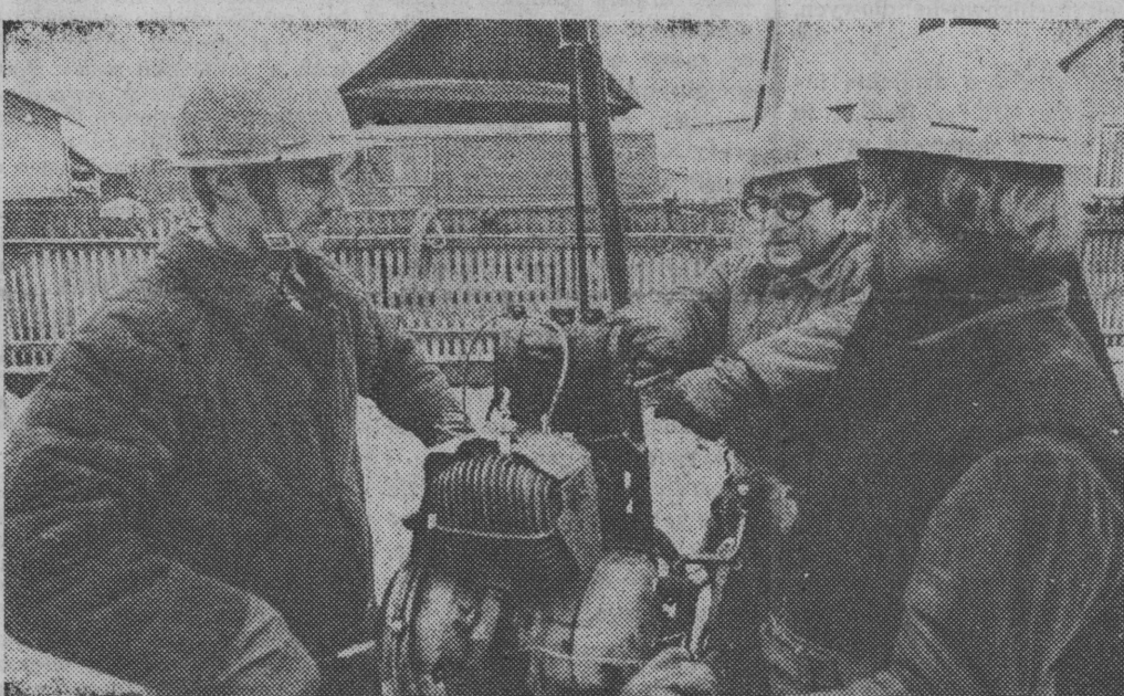
W związku ze stałym zapotrzebowaniem wsi na energię elektryczną zachodzi potrzeba gruntownej przebudowy linii energetycznych, średnich i niskich napięć. Dzięki przebudowie linii oraz znacznemu zwiększeniu liczby stacji transformatorowych poprawia się niezawodność dostaw, oraz jakość energii (choćby m.in. o likwidację spadków napięcia podczas godzin szczytowego poboru). Rzeszowski Przedsiębiorstwo Elektryczne i Techniczne, Oddział „Eltex” realizuje takie prace na terenie województw: rzeszowskiego, krosińskiego i przemyskiego.
