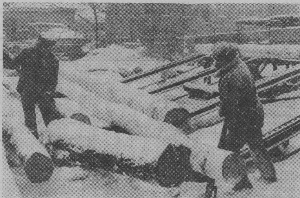
Część prac wykonywano na jezdni na powietrzu, bez względu na warunki atmosferyczne. Mieczysław Polejowski i Jan Rożnowski muszą więc pracować i w czasie śnieży.
