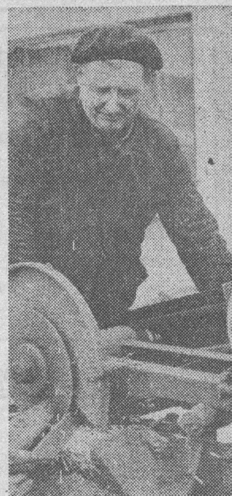
Teofil Dębiński jest autorem małego ale cennego usprawnienia. Skonstruował wykrotnik, który w znaczący sposób ułatwił produkcję ścieków do rur wiertniczych.
