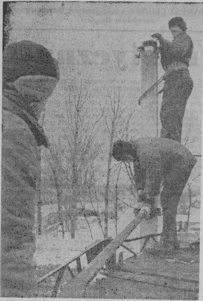
Urządzenia elektryczne zakładu brygada Mariana Mięskiego.
