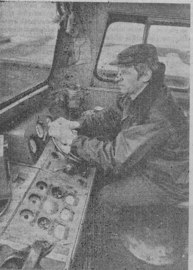
Maszynista Henryk Tumiel prowadzi pociąg ekip montażowych.
