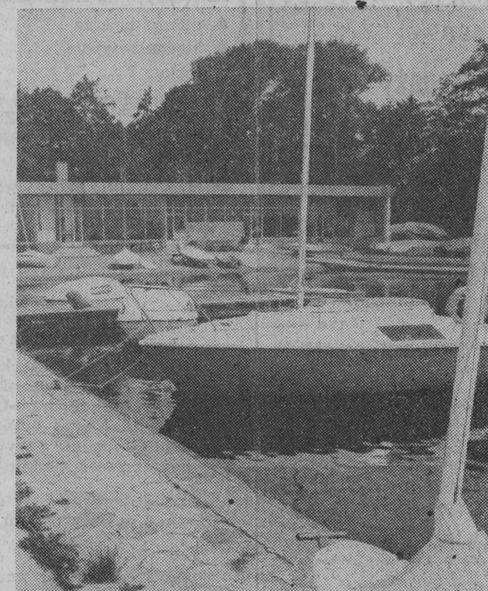
Widoczne nabrzeża portowe bazy Miedzyzskoleniowego Ośrodka Sportu Wodnych nad Niepocinem to jedna z prac wykonanych przez ludzi z PBWi w Głzycku.
