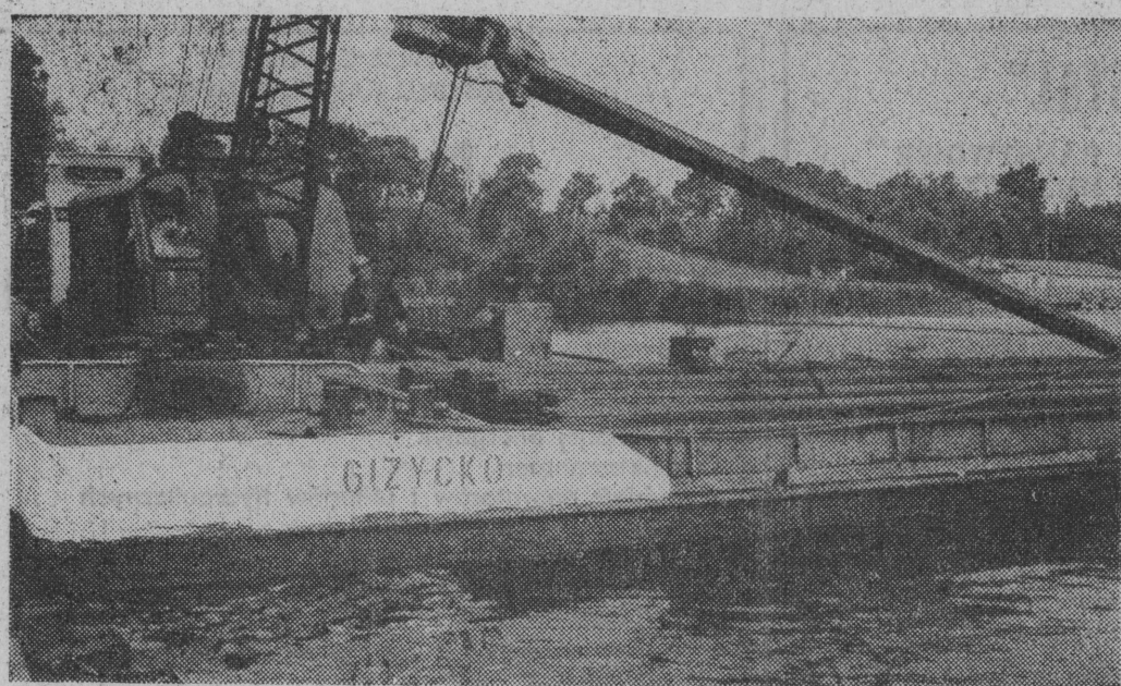
Prace przy ośrodku wypoczynkowym AZS w Wilkasach. Operator koparki — Leon Holownia i kierownik pogłębiarki — „Mazury” — Henryk Podkaura w trakcie umacniania nabrzeży.
