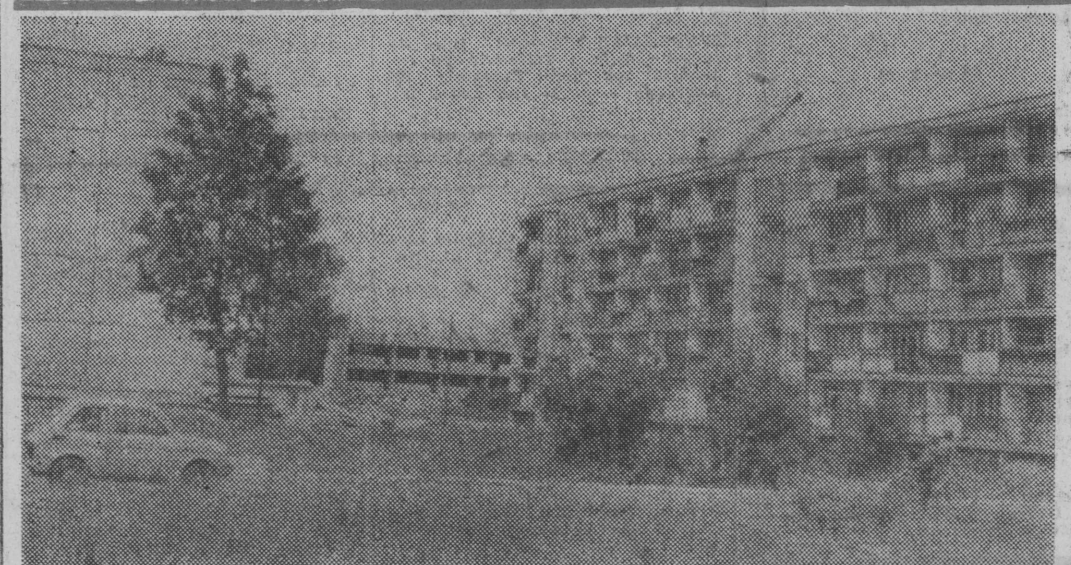
W Grajewie przy ul. Wojska Polskiego wyrastają nowe bloki mieszkalne.
