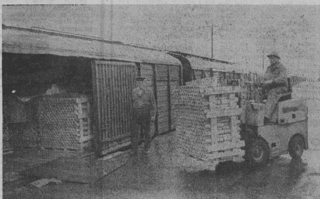
Mimo deszczu i chmur trwa przeładunek rurek drenarskich dla meliorantów z Sochaczewa.
