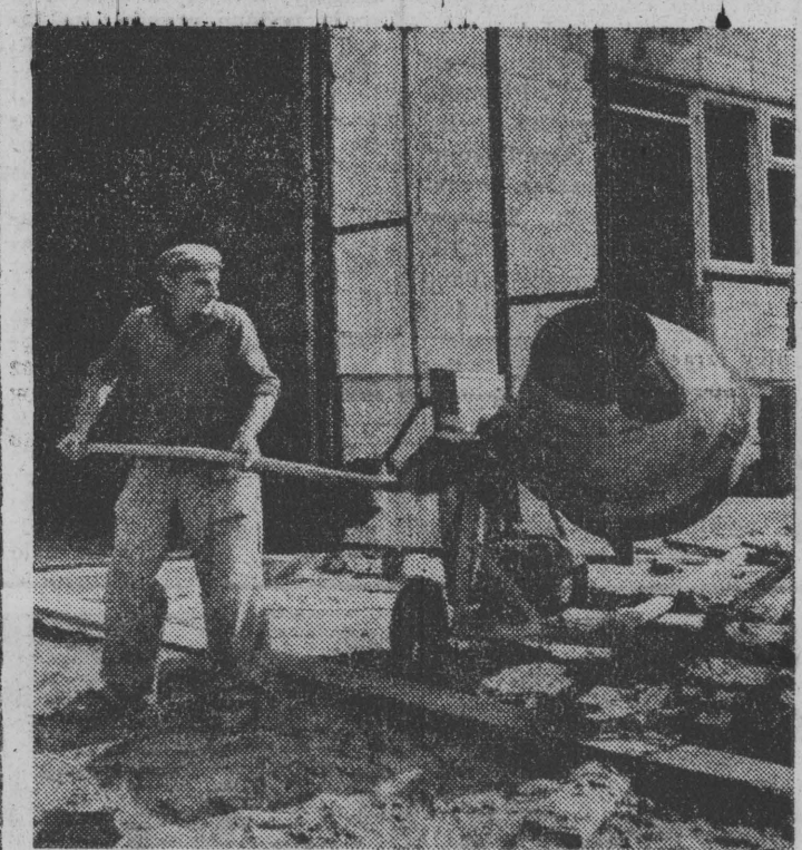
Przy betoniarce pracuje Zygmunt Kosewicz. Fot. ZDZISŁAW ZAREMBA
