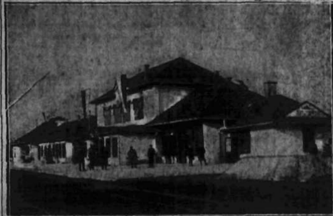
Nasza stacja graniczna od strony Czechosłowacji Zebrzydowice zyskała no- wy, na europejską modłę zakrojony budynek stacyjny.
