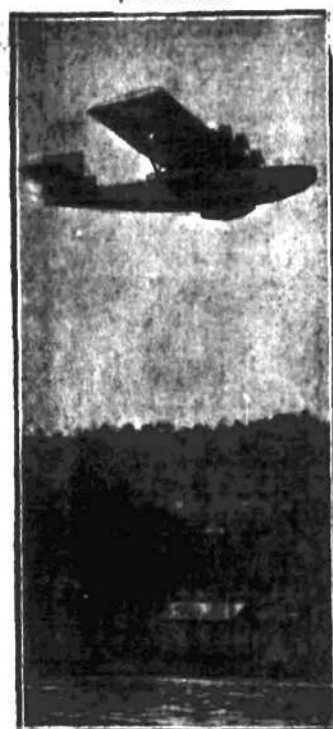
O trzech motorach konstrukcji M. Bes- sona długości 18 metr. o sile 420 HP. i możliwości lotu z szybkością 190 km. na godzinę.
