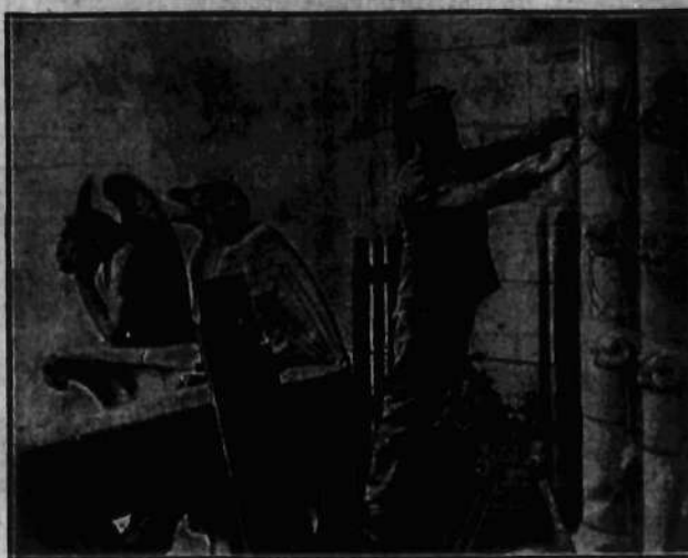
W tych dniach ukończono zakładanie kabli elektrycznych na froncie katedry „Notre Dame” w Paryżu, celem oświetlenia jej wieczorami i nocami. Na lewo słynne „Chimery” katedry.
