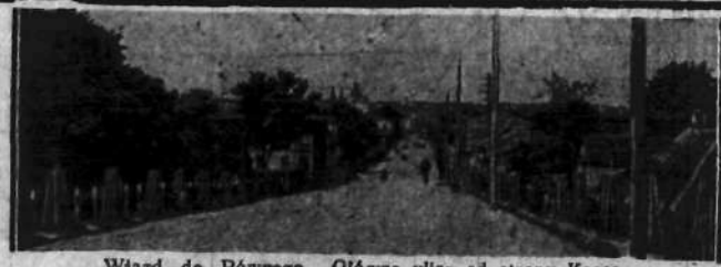
Wjazd do Równego. Główna ulica od strony Korca.
