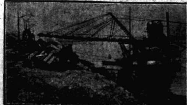
Prace nad regulacją Wisły w obrębie Warszawy nie ustają. Na zdjęciu maszyna bagrowa „Polka”, posługująca dno Wisły.
