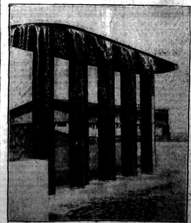
Do nowych urządzeń zdrowotnych Ciechocinka należą wspaniałe kąpiele cieplnicowe. Oto pomysłowy wodotrysk, który równocześnie jest efektem dekoracyjnym i filtrem, odbarwiającym wodę ze składników, nadających jej przykry, brzyzy kolor. Do basenu kąpielowego spływa woda idealnie przefiltrowana.
