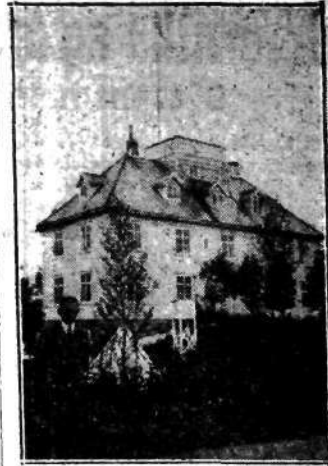
Budynek obserwatorium geofizycznego w Tromsø, gdzie został ustawiony atmoradiograf dyr. Lugeona.
