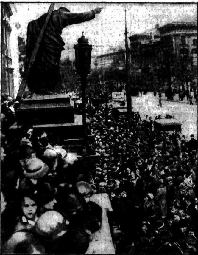
Tłum zebrany przed kościołem św. Krzyża po wczorajszej katastrofie zawalenia się posadzki kościoła, w czasie której zostało 12 osób rannych.
