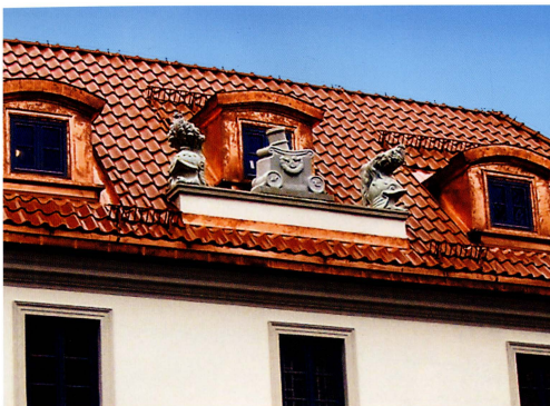
12. Attyka na Arsenale po montażu kompozycji rzeźbiarskiej. Fot. J. Grygorczuk Arsenal attic after the instalment of the sculpted composition. Photo: J. Grygorczuk.
