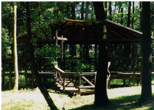
18. Park plebański, zadaszenie nad Świętym Źródłem. Fot. Z. Cybulko, 2015 Rectory park, roof over the Holy Spring. Photo: Z. Cybulko, 2015.
