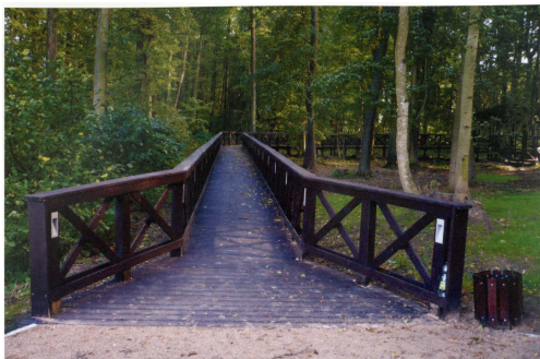
17. Park plebański, kładka wiodąca do Świętego Źródła. Fot. J. Rak, 2013. Rectory park, footbridge leading to the Holy Spring. Photo: J. Rak, 2013.
