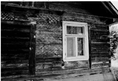
6. Wschodnia ścianabudynku mieszkalnego w Mielewszczyźnie, do budowy której użyto drewna z rozebranego dworu. Fot. D. Krasnodębski. Eastern wall of a residential building in Mielewszczyzna, erected with timber from a demolished manorhouse. Photo: D. Krasnodębski.
