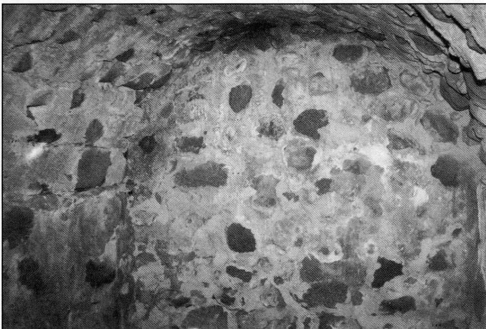
11. Wygląd sklepu w naprzeciwnym końcu (przy praczkarni). Wymiary wewnętrzne piwnicy po piekarnią: długość 4,5 m, szerokość - 2,4-2,45, wysokość 2,5-2,6.
