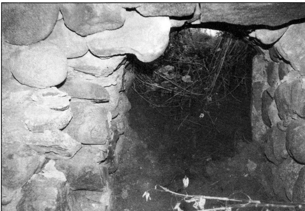
9. Wejście (widok od wewnątrz piwnicy).
