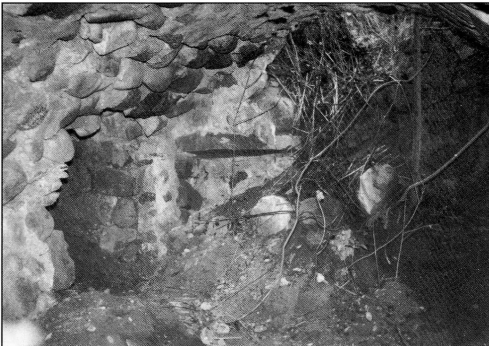
10. Spojrzenie na fragment piwnicy od strony drugiego sadu. Po lewej widok przysypanego częściowo wejścia, w prawym górnym rogu olbrzymia dziura w stropie.
