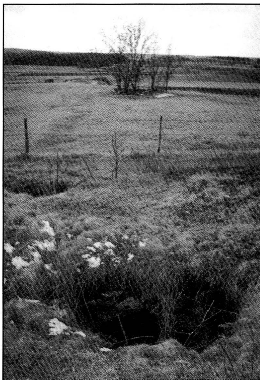
8. Piwnica pod izbą czeladną (piekarnią). Zawalone i zarośnięte wejście (od strony klasztoru) - w oddali widoczny wielki sklep, zarośnięty drzewami - patrz zdjęcia 12-14.
