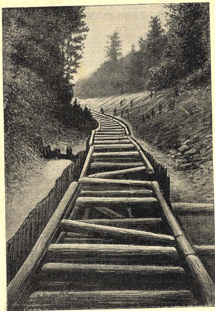
Sztolnia Ponikowska pod Olkuszem—sztuczny kanał, odprowadzający wody z kopalni olkuskiej.
