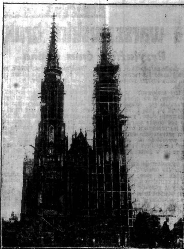
Piękna wieża gotycka kościoła św. Floriana na Pradze będzie musiała ulec rozbiórce ze względu na niepokojące rysy.
