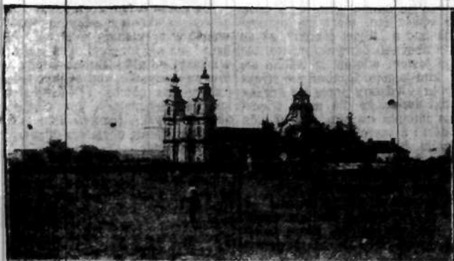
Widok kościoła św. Wincentego Kadłubka w Jędrzejowie przed zniszczeniem
