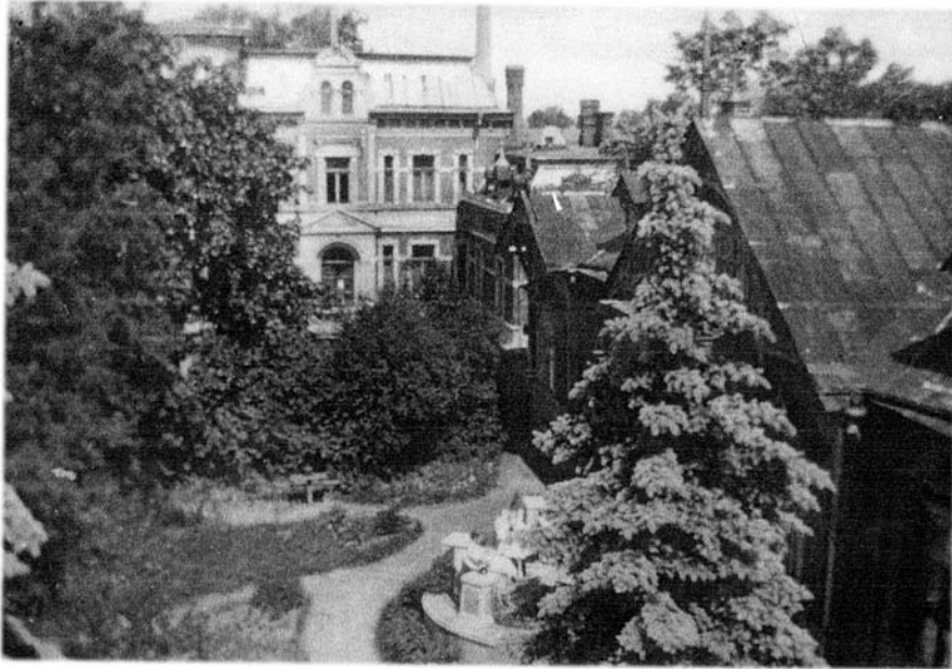
Dom przy ulicy Św. Jańskiej z „lotu ptaka”
