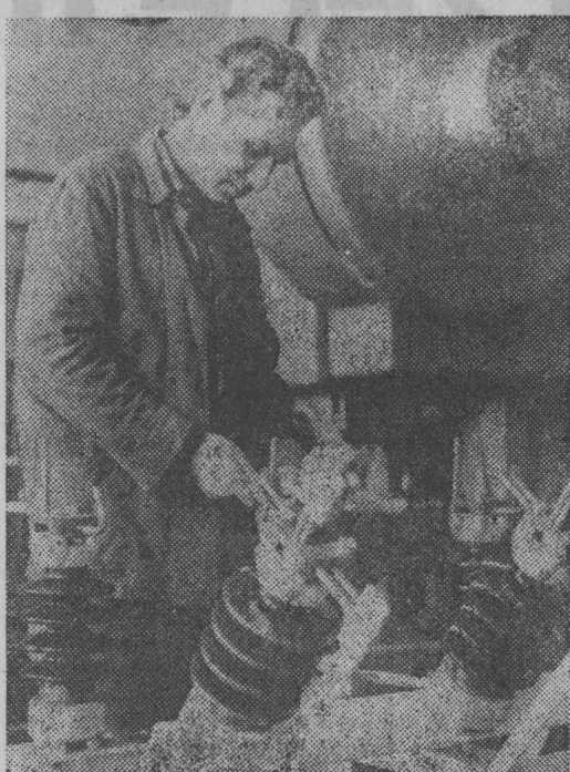
Tadeusz Kraszewski przy montażu odłącznika z tzw. nożami uzmienniczymi: — Jest w tym sporo naszych rozwiązań...
