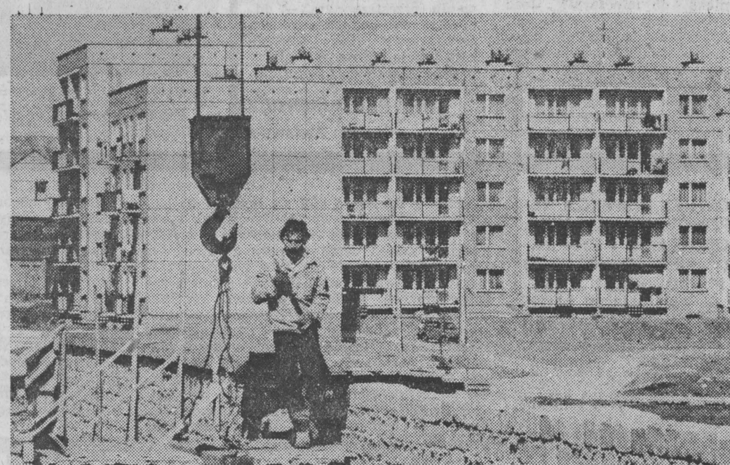
Sprawą niezmiernie ważną jest budowa — obok domów mieszkalnych — tzw. obiektów towarzyszących, jak tego (na pierwszym planie) przedszkola.
