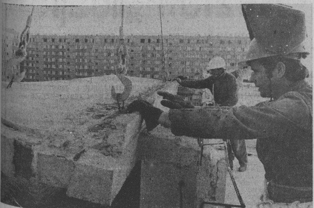
Montaż jednego z większych elementów.
