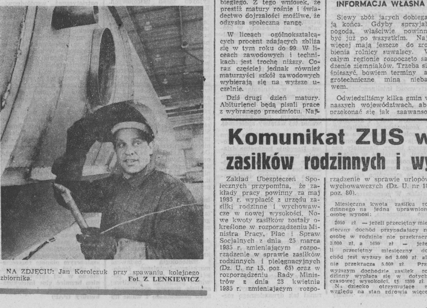
NA ZDJĘCIU: Jan Korolczuk przy spawaniu kolejnego zbiornika. Fot. Z. LENKIEWICZ
