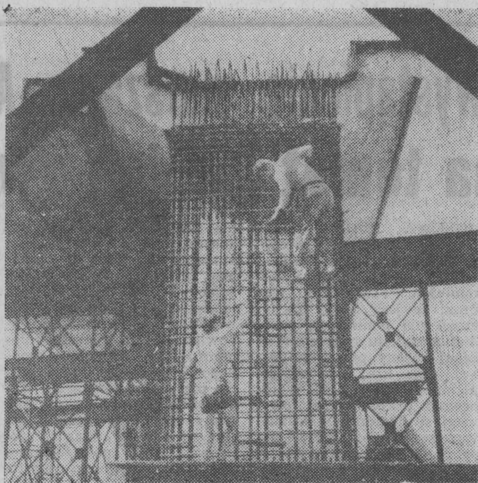
Na budowie Trasy Toruńskiej w Warszawie trwają prace przy wiaduktach nad ulicą Marymoncką. Jeżeli dopisze pogoda i nie będzie „trudności obiektywnych”, ekipa budowlana chce skończyć prace przy wschodniej jezdni wiaduktu najpóźniej do 22 lipca.
