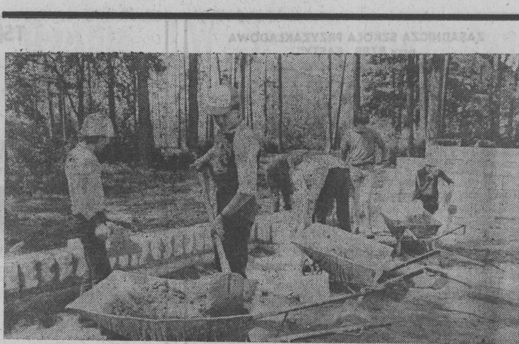
Nie poprzestają na warsztatach. Młodzież w ramach zajęć praktycznych buduje kolejny obiekt.
