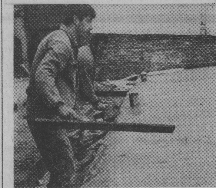
Na wszystkich budynkach gotowe są już dachy. Fot. JANUSZ KŁEWSKI
