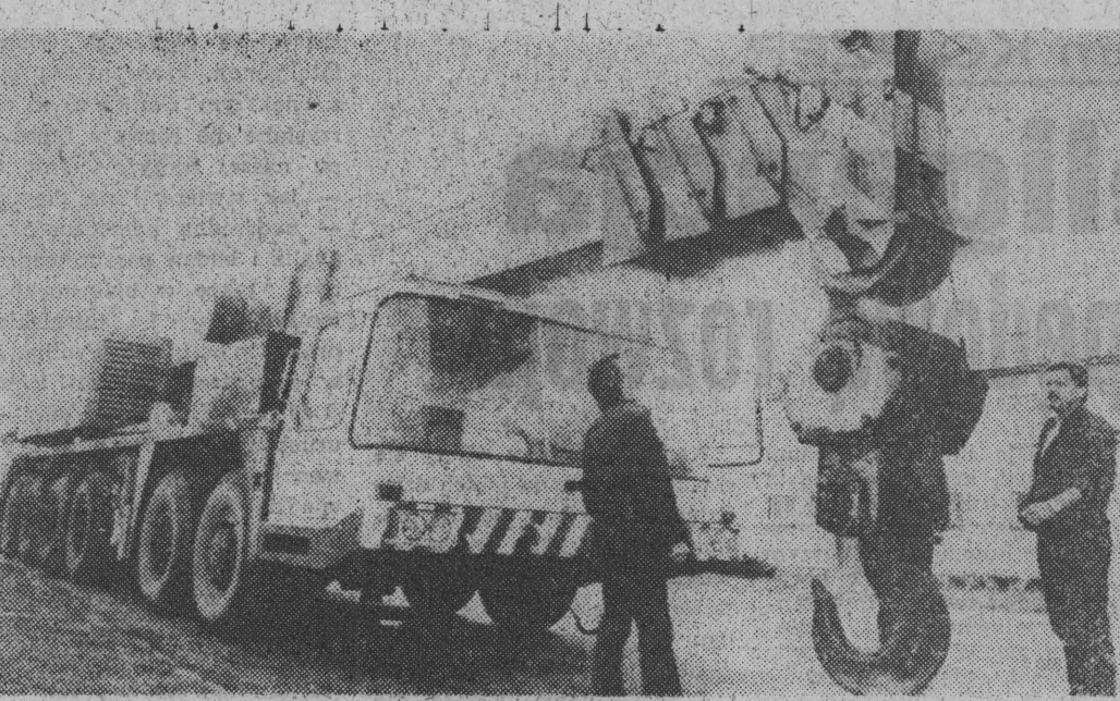
W Instytucie Maszyn Budowlanych w Kobylińcu przechodzi próby dźwign „Hydros T-632”. Jego budowa to efekt współpracy naukowo-technicznej Instytutu Polski i ZSRR. „Hydros T-632” o udźwign 63 ton budowany będzie z części wytwarzanych w Polsce oraz spradowanych z ZSRR. Strona polska wytwarzać będzie podwozia i wysięgniki a strona radziecka dostarczy części obrotowe. Montażem będzie zajmować się „Mostostal” w Polsce a w ZSRR Zakłady w Odesie. Produkcja seryjna rozpocznie się w przyszłym roku.
