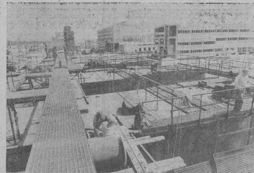
Teren budowy koksowni Huty „Katowice” obejmuje 230 hektarów; powstaje na nim 330 obiektów.
