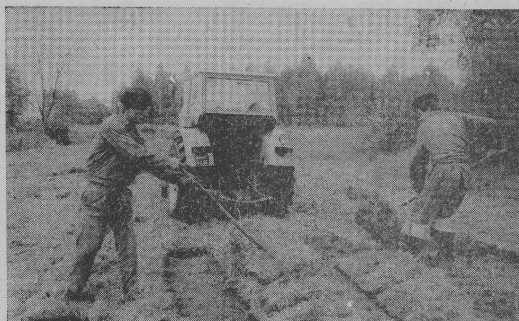
Przy zrywaniu darni, potrzebnej do wyłożenia brzegów rowów melioracyjnych trzeba się tego natrudzić, ale i dobrze zarobić przy takiej robocie.
