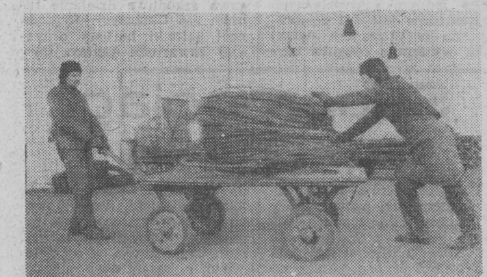
Jan Krusznicki (od lewej) i Andrzej Mroczek przewożą kolejną partię stali zbrojeniowej na swe stanowiska pracy.
