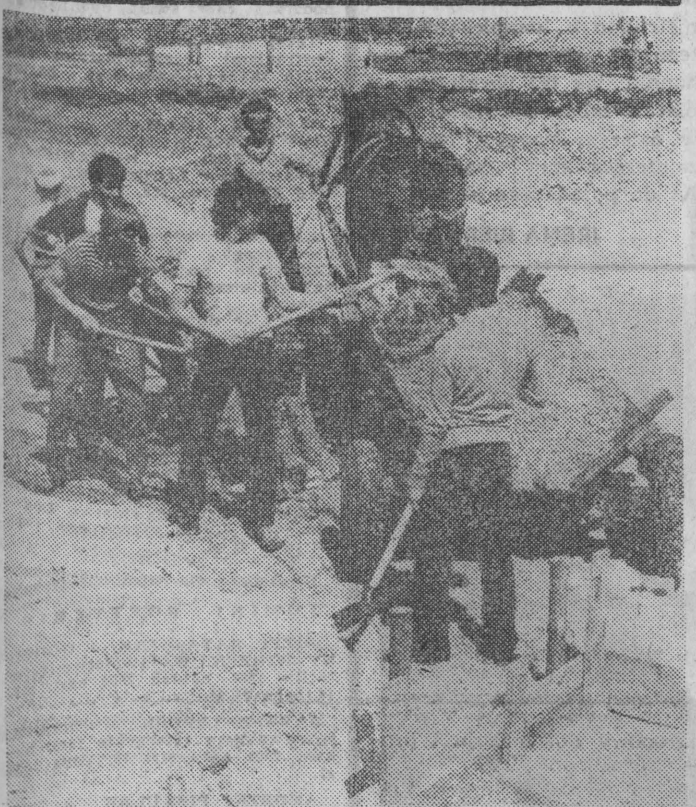
W Czarnej Wsi Kościelnej członkowie ZSMP pracowali przy budowie nowej szkoły.
